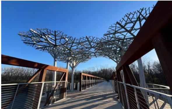
Athene Bridge, West Des Moines
